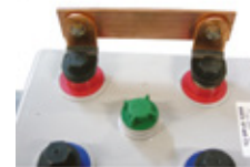
Abb. 5-18: 2 Montage der Endpole (Anschlussplatten)
